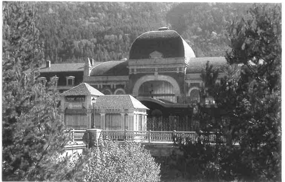
Canfranc : la façade de la gare
